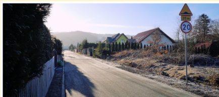
► Remont ul. Reja w Janowicach Wlk. Dofinansowanie z Funduszu Dróg Samorządowych.
