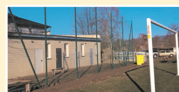
► Remont elewacji szatni GLKS „Rudawy” w Janowicach Wlk. Dofinansowanie z UMWD.
