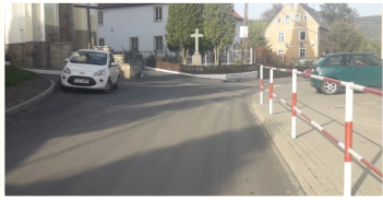
► Remont ul. Partyzantów w Janowicach Wlk. Dofinansowanie z Funduszu Popowodziowego.
