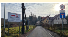
► Remont ul. Robotniczej w Janowicach Wlk. Dofinansowanie z Rządowego Funduszu Dróg.
