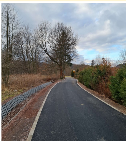
► Remont ul. Kolejowej w Janowicach Wlk. Dofinansowanie z Funduszu Rozwoju Dróg Samorządowych.
