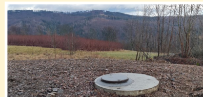
► Przyłącze wodociągowe (4km.) do gm. Marciszów. Dofinansowanie z Funduszu Inwestycji Lokalnych.
