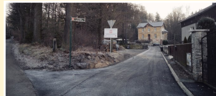
► Remont ulicy od ul. Parkowej do ul. 1 Maja w Janowicach Wlk. Dofinansowanie z Funduszu Dróg Samorządowych.
