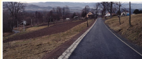
► Remont drogi w Komarnie. Dofinansowanie z Funduszu Dróg Samorządowych.
