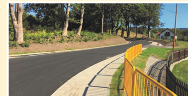
► Przebudowa drogi powiatowej Radomierz-Janowice Wlk. Dofinansowanie gminy.
