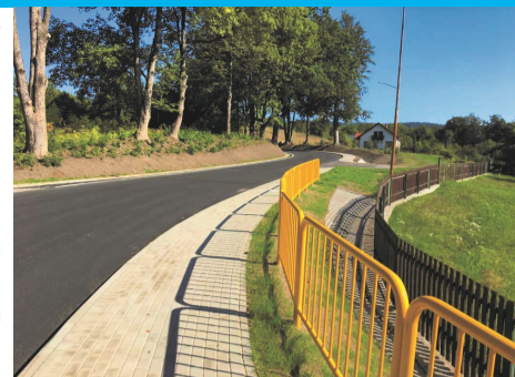
► Efekt końcowy przebudowy (fot. Powiat Jeleniogórski)
