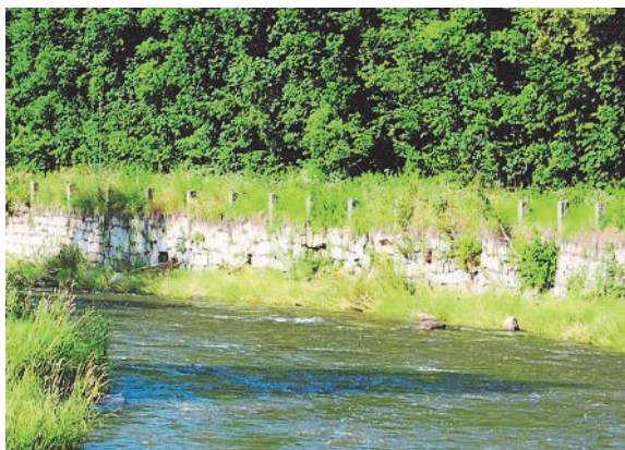
Odcinek muru, który zostanie odbudowany
