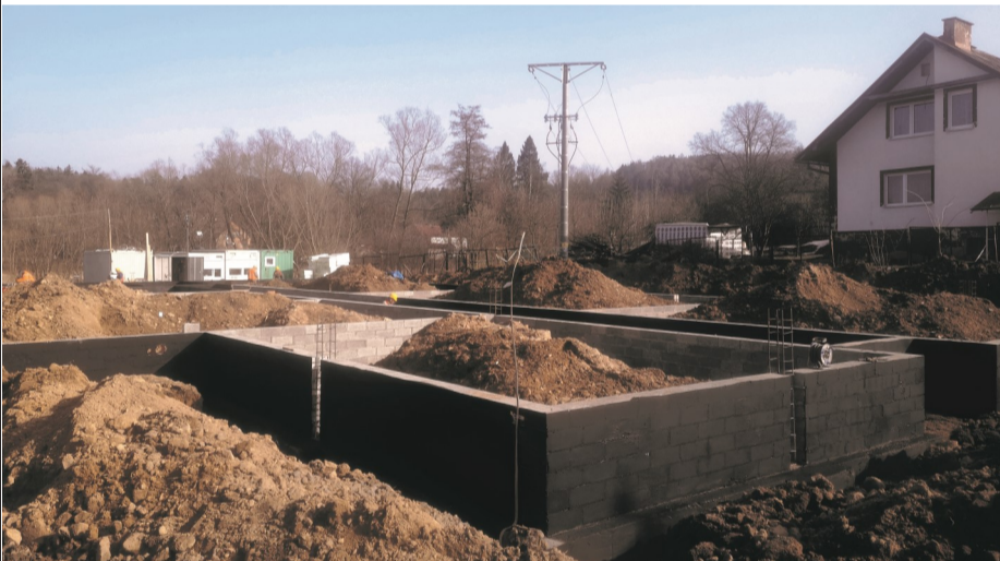
Plac budowy (fot. H. Tyndyk)
