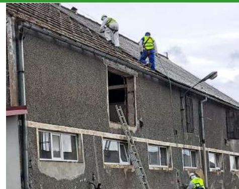
► Usuwanie azbestu (fot. E. Chrzastowska)
