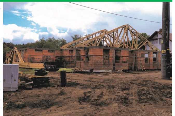
► Montaż dachu (fot. Emilia Parzygnat)
